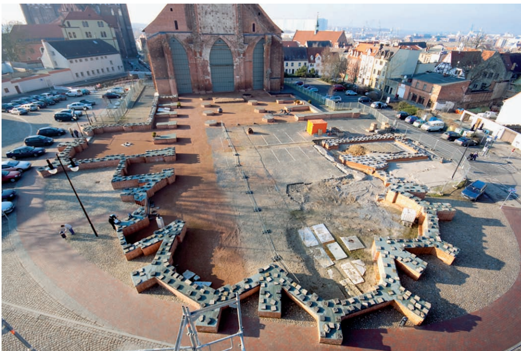
Abb. 6. Hansestadt Wismar, Marienkirche, der sichtbar gemachte Grundriss des Kirchenschiffes, die neuen Mauern stehen auf den erhaltenen Fundamenten, 2009.
