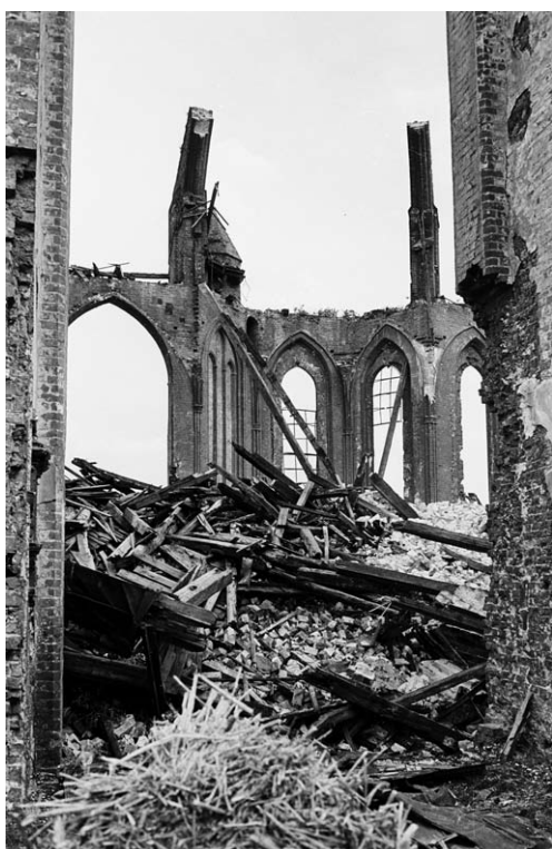
Abb. 4. Hansestadt Wismar, Marienkirche, Blick in den Chor während der Sprengarbeiten, August 1960.
