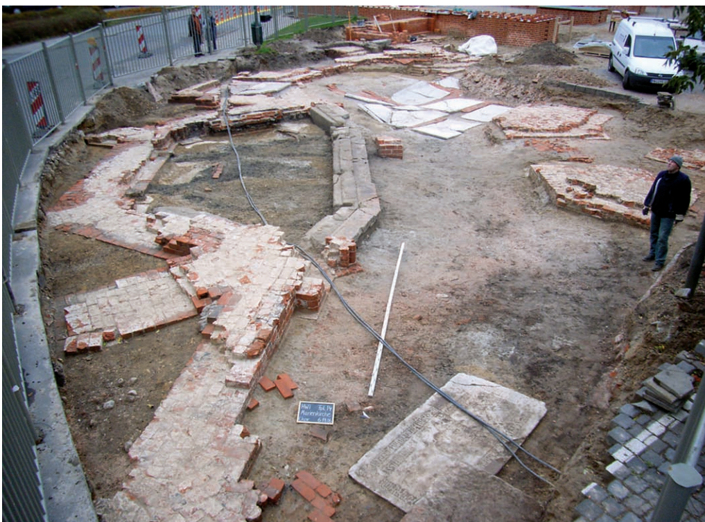
Abb. 9. Hansestadt Wismar, Marienkirche, freigelegtes Mauerwerk des um 1320 begonnenen Umgangschores, Blick nach Südwesten, 2006.
