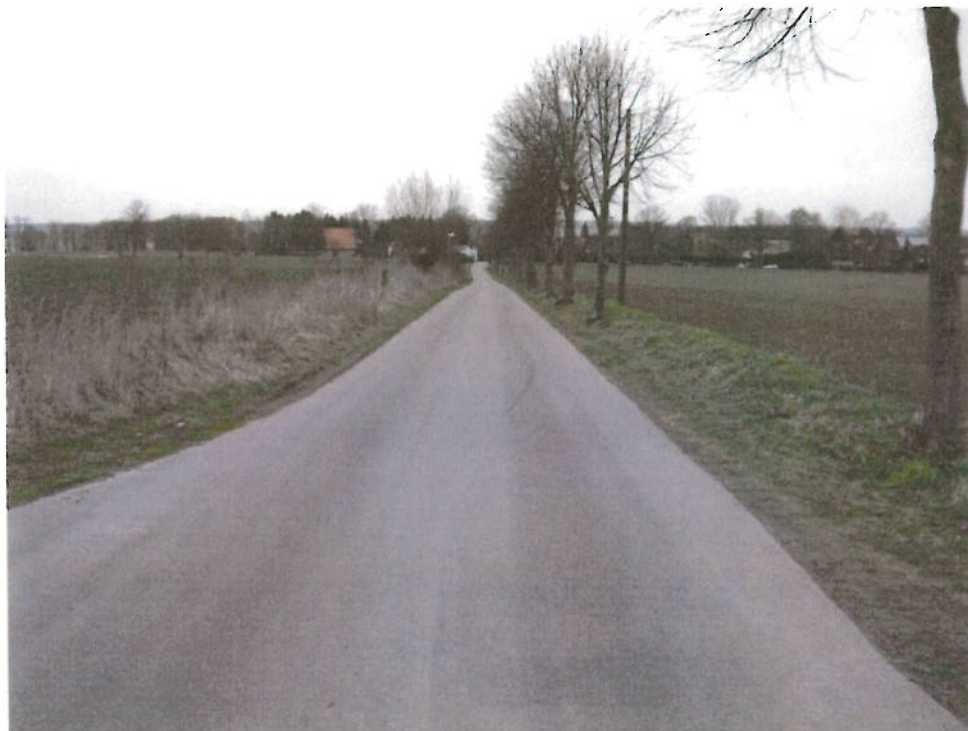
Bild 8: in Asphalt befestigter ländlicher Weg nach Hundorf - Blickrichtung Nordosten
