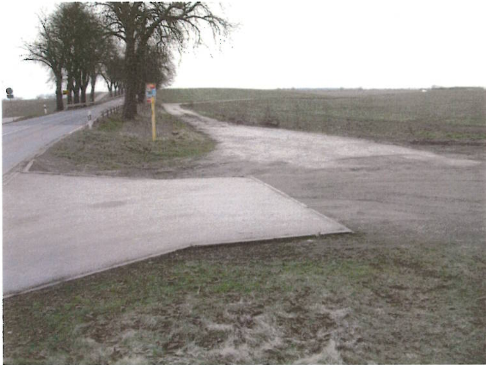
Bild 1: befestigte Zufahrt zur B 106 nördlich der Kirche - Blickrichtung Norden
